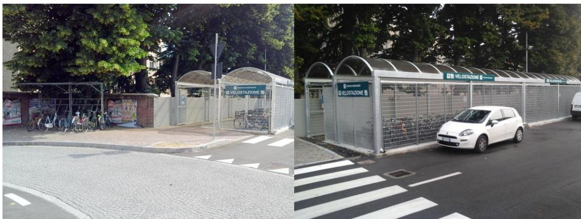
La Velostazione, attrezzata con 24 stalli per biciclette videosorvegliata ed illuminata, è stata realizzata in una struttura completamente coperta e chiusa sui lati da recinzione tipo orso-grill. Ulteriori stalli esterni sono di prossima installazione.
